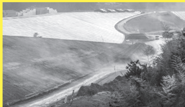
宮城県気仙沼市小泉海岸/陸と海を遮断するかのような高さ14.7メートルの防潮堤
