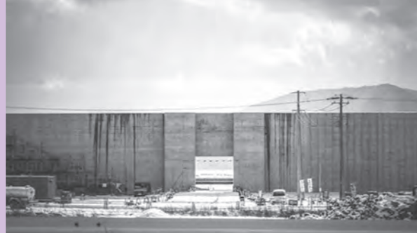
岩手県陸前高田市／現在、建設仮設住宅の居住者が3県で最も多い陸前高田市の海岸では、防潮堤建設が続いていた。
